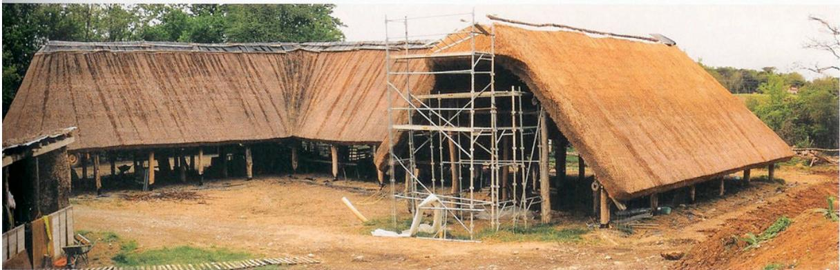
**MATÉRIAU PRINCIPAL DE LA CONSTRUCTION, le bois est à la fois un élément de structure, de fondation, de charpente et de couverture. Ce sont ces qualités intrinsèques (flexion, compression, tension et résistance aux agressions climatiques) qui permettent une telle profusion. Toutes les parties sont utilisées, du cœur à l'écorce.**
