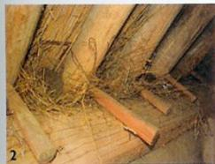
1. LA PANNE FAÏTIÈRE, de la taille d'un chevron, est « flottante » et repose sur le chevronnage.
